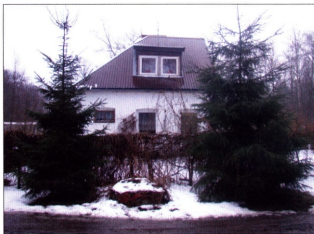
Widok ocalałego fragmentu budynku szkolnego od strony zachodniej.
